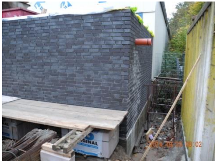
Erweiterung Halle, Osnabrück – Verblendarbeiten
