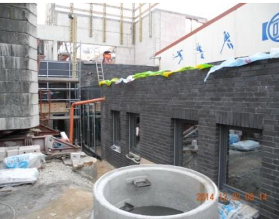
Erweiterung Halle, Osnabrück – Verblendarbeiten
