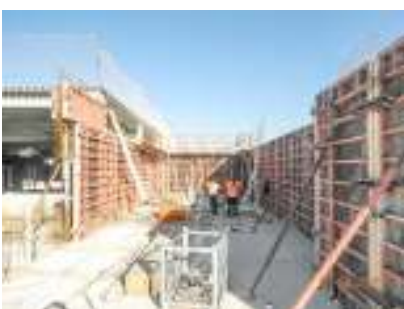
NB Büro- u. Produktionsgeb. Köln, Schal-, und Betonarbeiten
